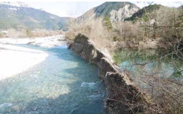
Travaux d'urgence permettant d'empêcher la capture d'une ancienne gravière par le Bez à Menglon
