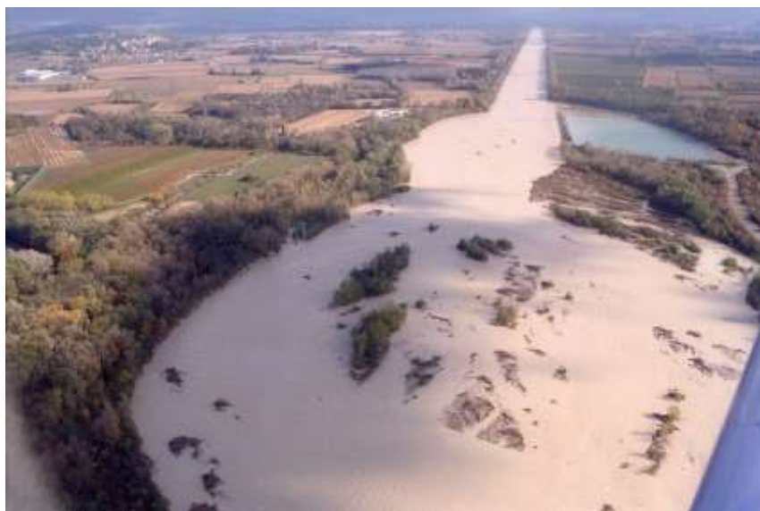
Endiguement Alex-Grâne et zone de ramières aval
