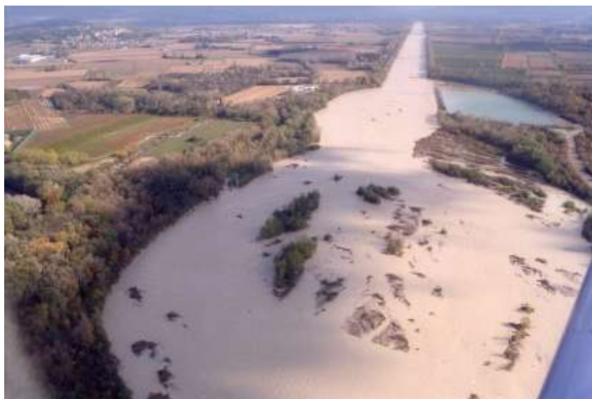
Endiguement Allex-Grâne et zone de ramières aval
