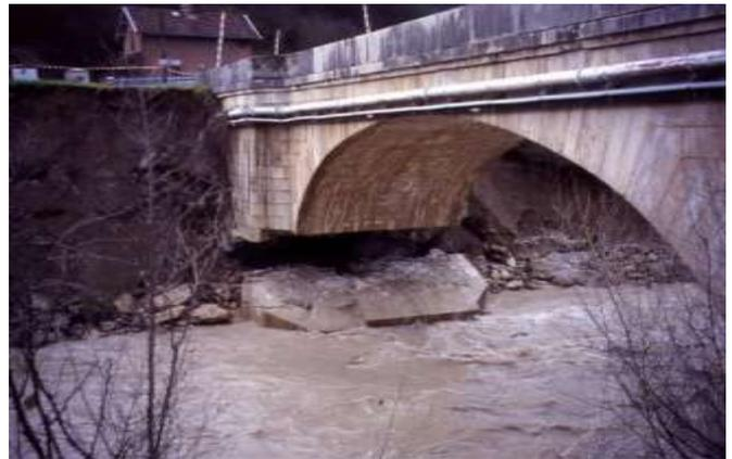
PHOTO 1 : AFFOUILLEMENT DU PONT DES CHAINES – DIE
