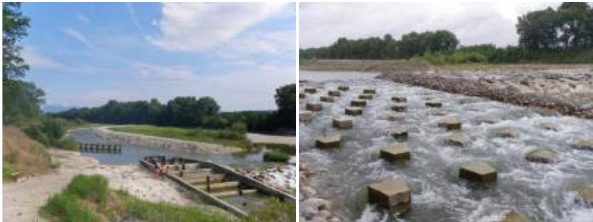
Le Seuil des Pues en juillet 2010 (à gauche) et en juin 2011 (à droite) équipé d'une passe permettant la circulation des aprons
