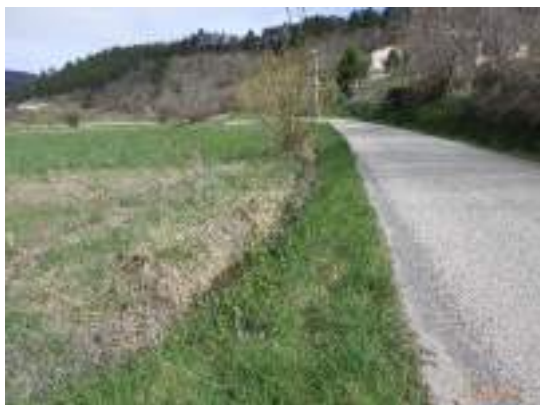
Figure 50 : Fossé drainant le long de la D543a
