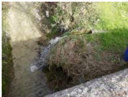
Figure 51 : Exutoire dans le ruisseau de Marignac
