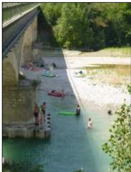
**Figure 84 : Les piles affouillées du pont de la Drôme.**
