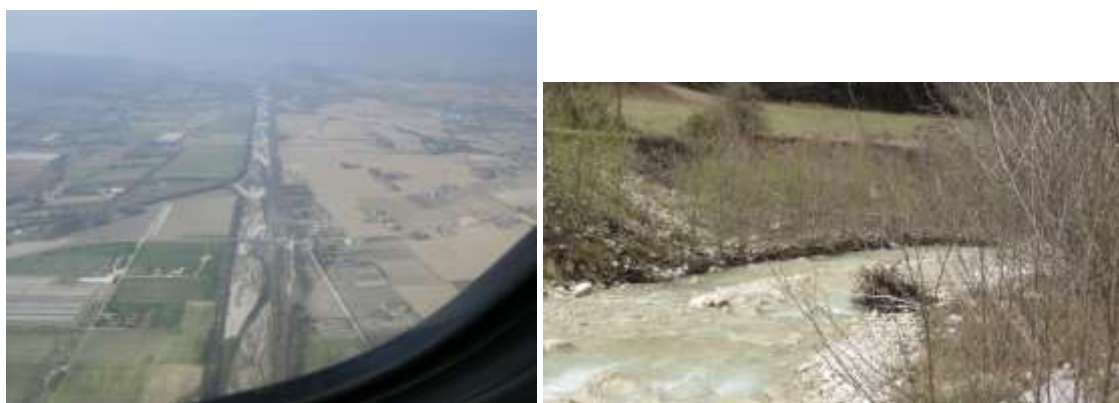
Fig. 4. Perte de milieux alluviaux / banalisation des milieux dans l'endiguement d'Allex-Grâne – Erosion de berges d'une parcelle agricole
