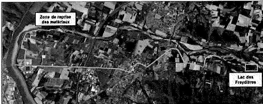
Figure 3 : Itinéraire des camions entre la zone de stockage des matériaux et le Lac des Freydières (AVP, CNR)
