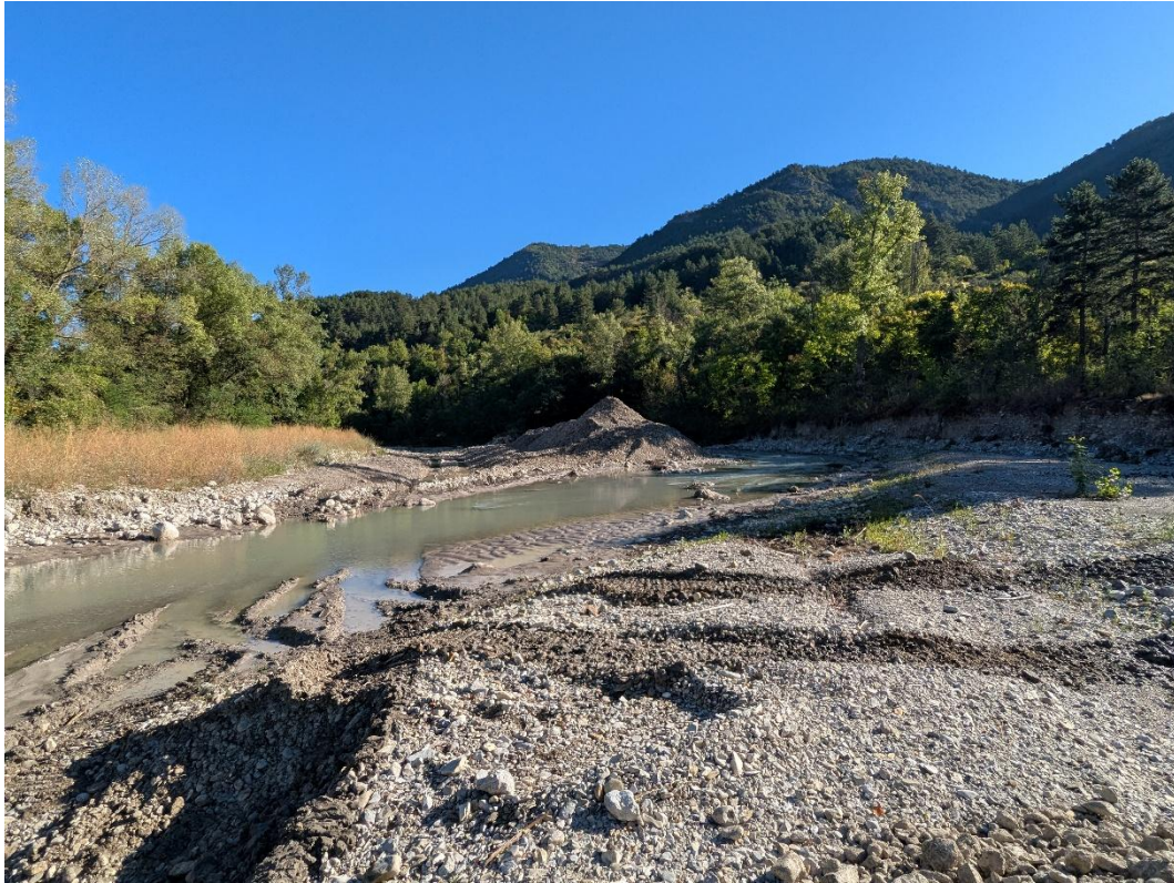
Travaux de terrassements sur le site de « La Chanau » - communes de Luc et Montmaur en Diois
