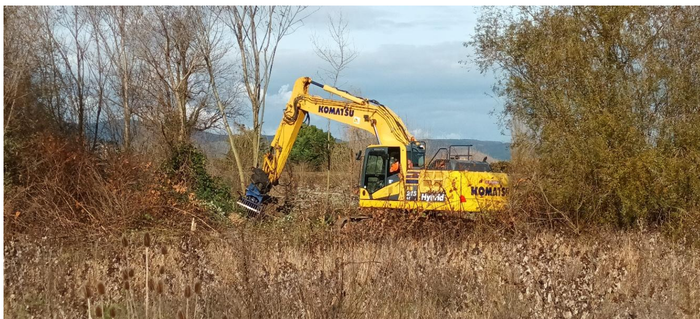
Scarification d'un atterrissement à l'entrée du méandre Paleyre (Livron)
