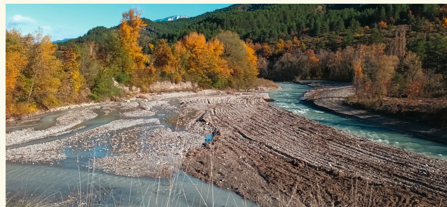
Travaux sur la Drôme à Luc-en-Diois et Montlaur-en-Diois - 2025
